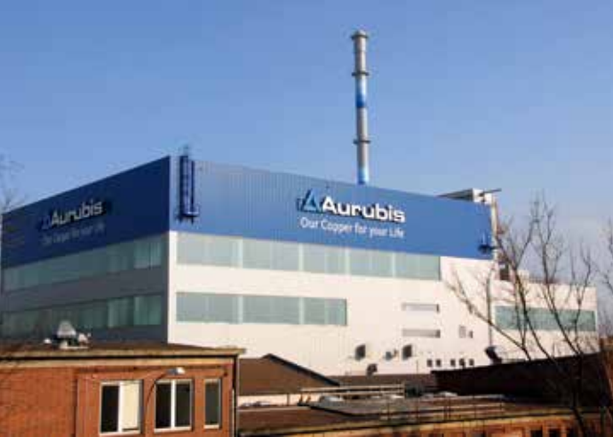
Gebäude der neuen Anodenschlammverarbeitung
